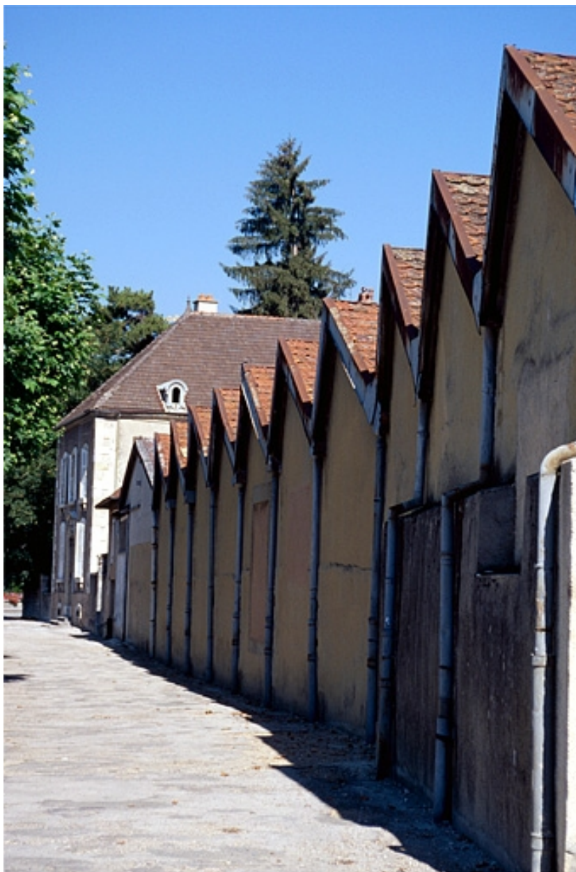
Façades sud et sheds des magasins industriels.
