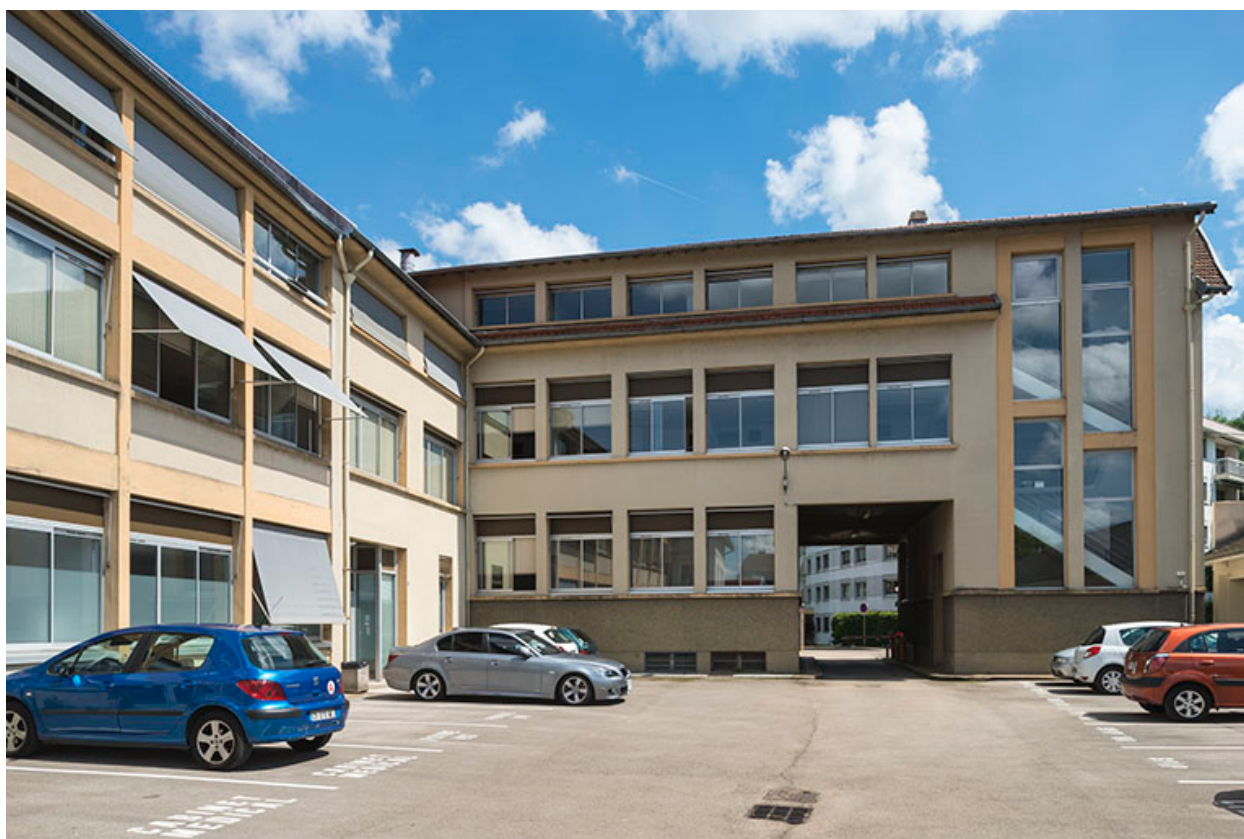
Bâtiment d'entrée. Façade nord.
