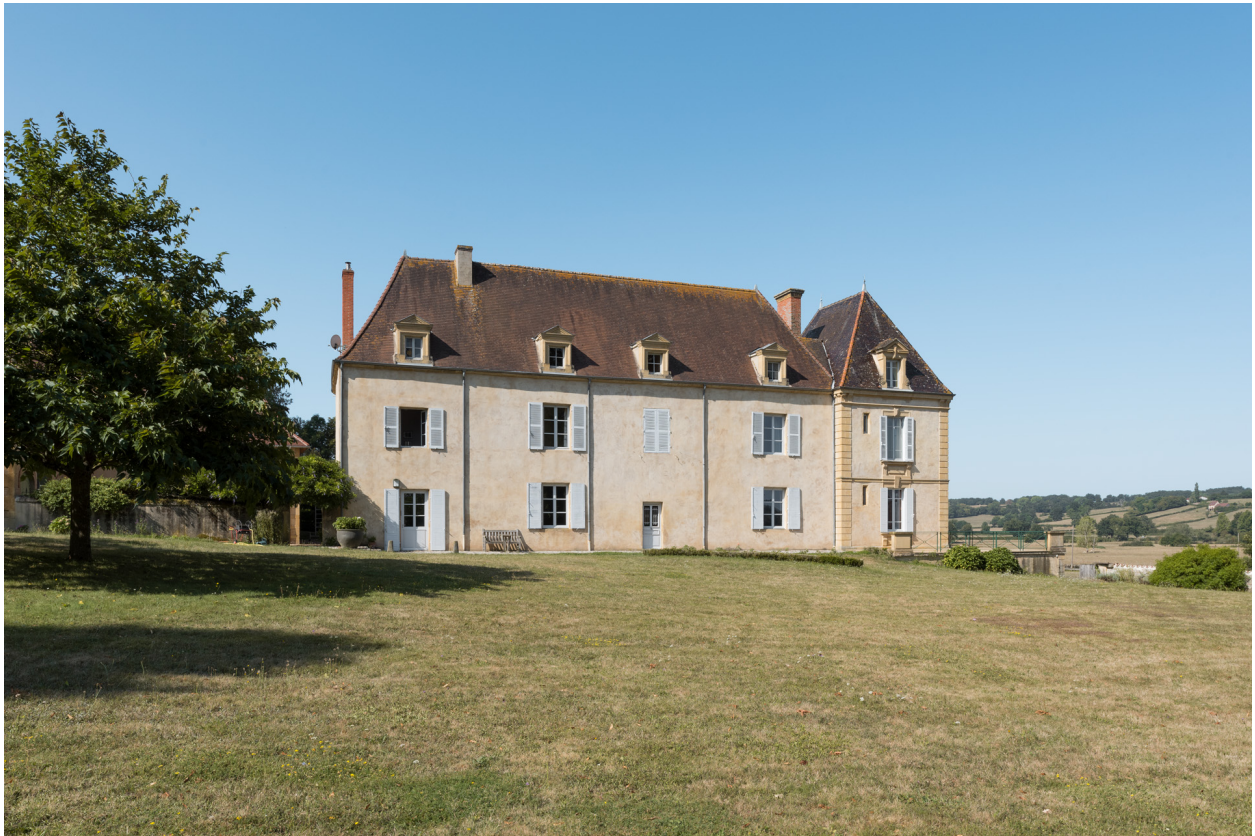
Vue du chateau depuis le parc au nord-est. Façade postérieure.
