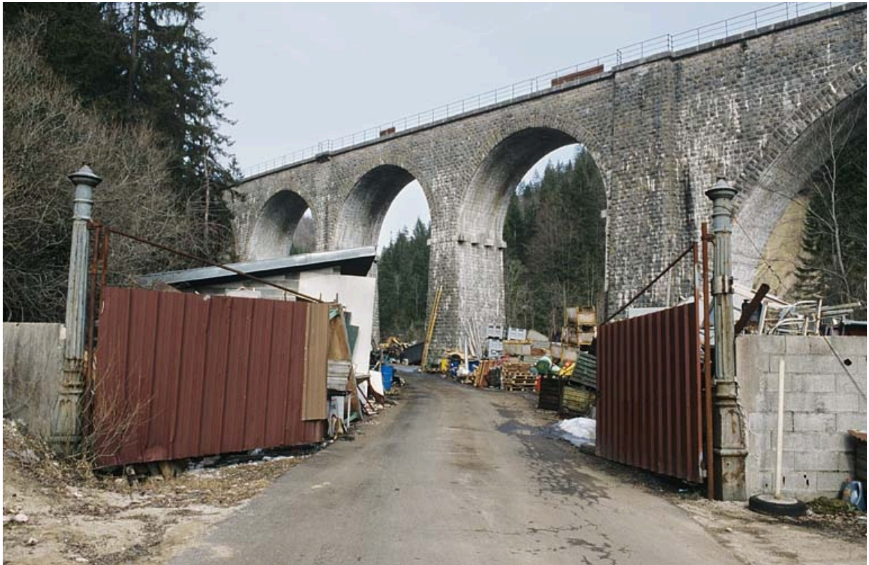
Elévation occidentale (extrémité côté Andelot-en-Montagne), depuis l'ouest.
