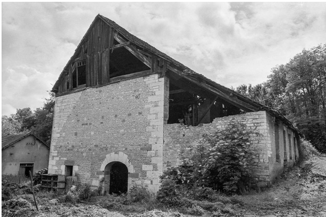
Bâtiment du haut fourneau en 1980.
