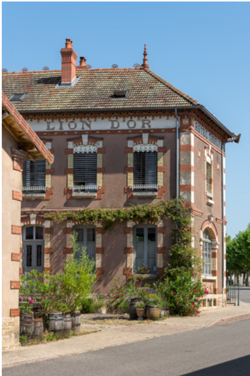
Hôtel-restaurant, vu du sud (vue rapprochée).
