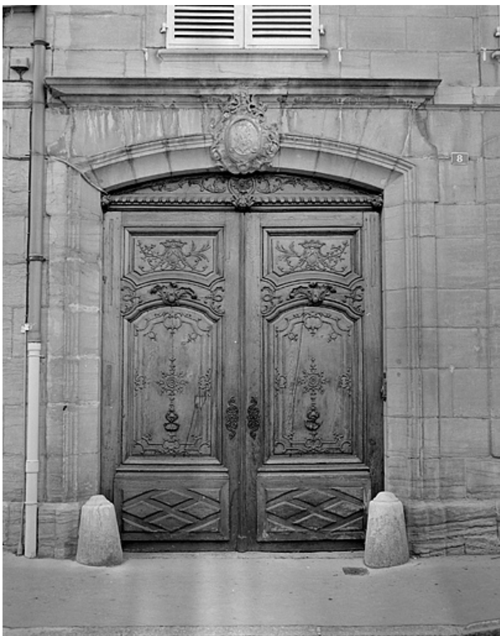
Portail de la façade antérieure.
