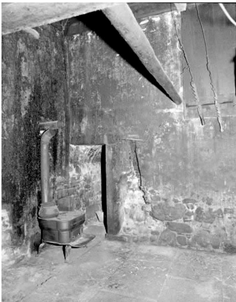
Intérieur : base du petit "tué" et bûcher, en 1976.
