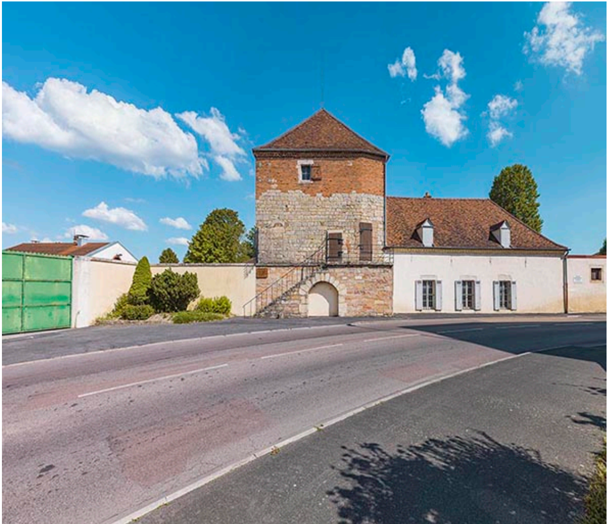
La tour Belvoir, face côté gorge.
