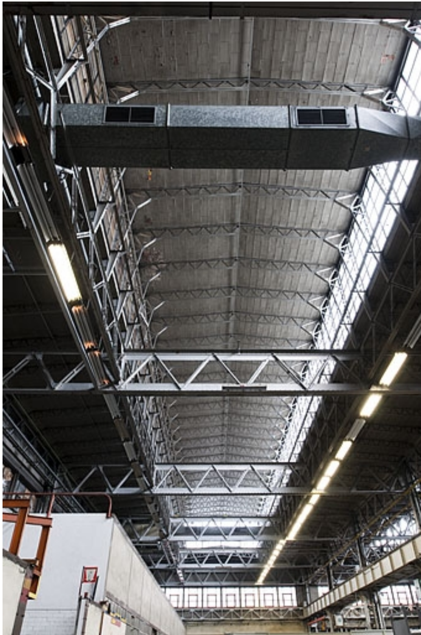
Atelier à ossature métallique. Vue axiale.
