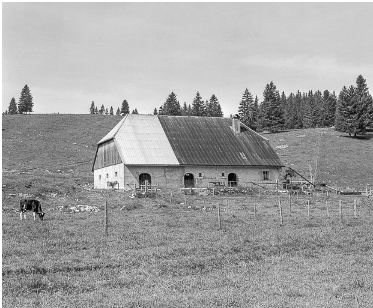
Pignon postérieur et goutterot gauche.
