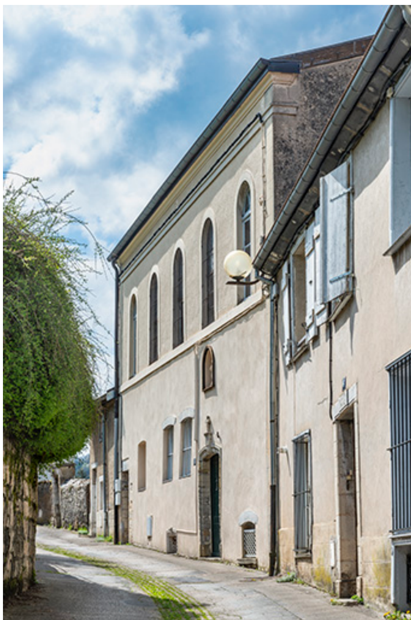
Façade antérieure vue de trois quarts droite.
