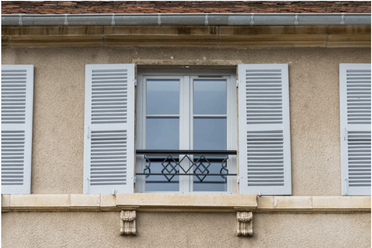
Façade antérieure : fenêtre du 2e étage.
