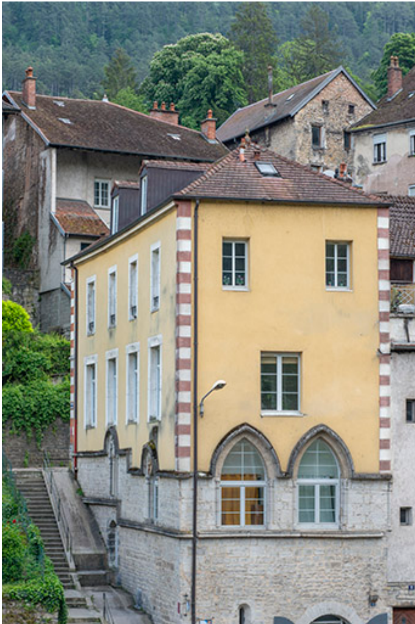
Partie supérieure, depuis l'ouest.
