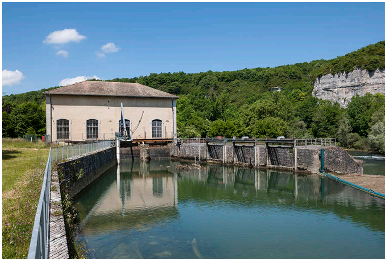
La centrale et son déversoir, depuis l'amont.
