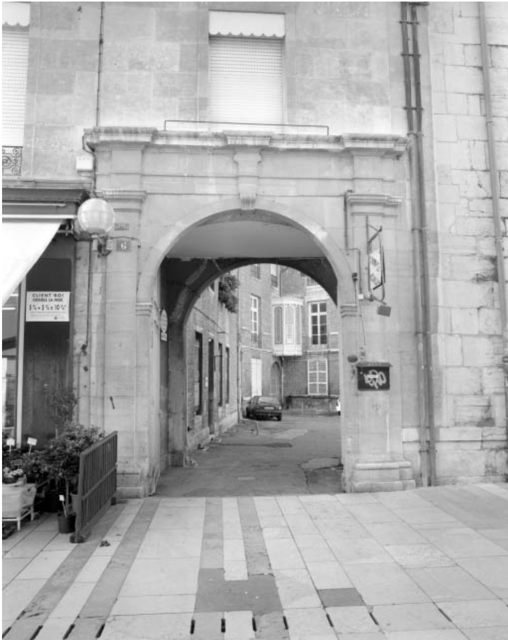
Façade sur rue : détail de l'entrée cochère.
