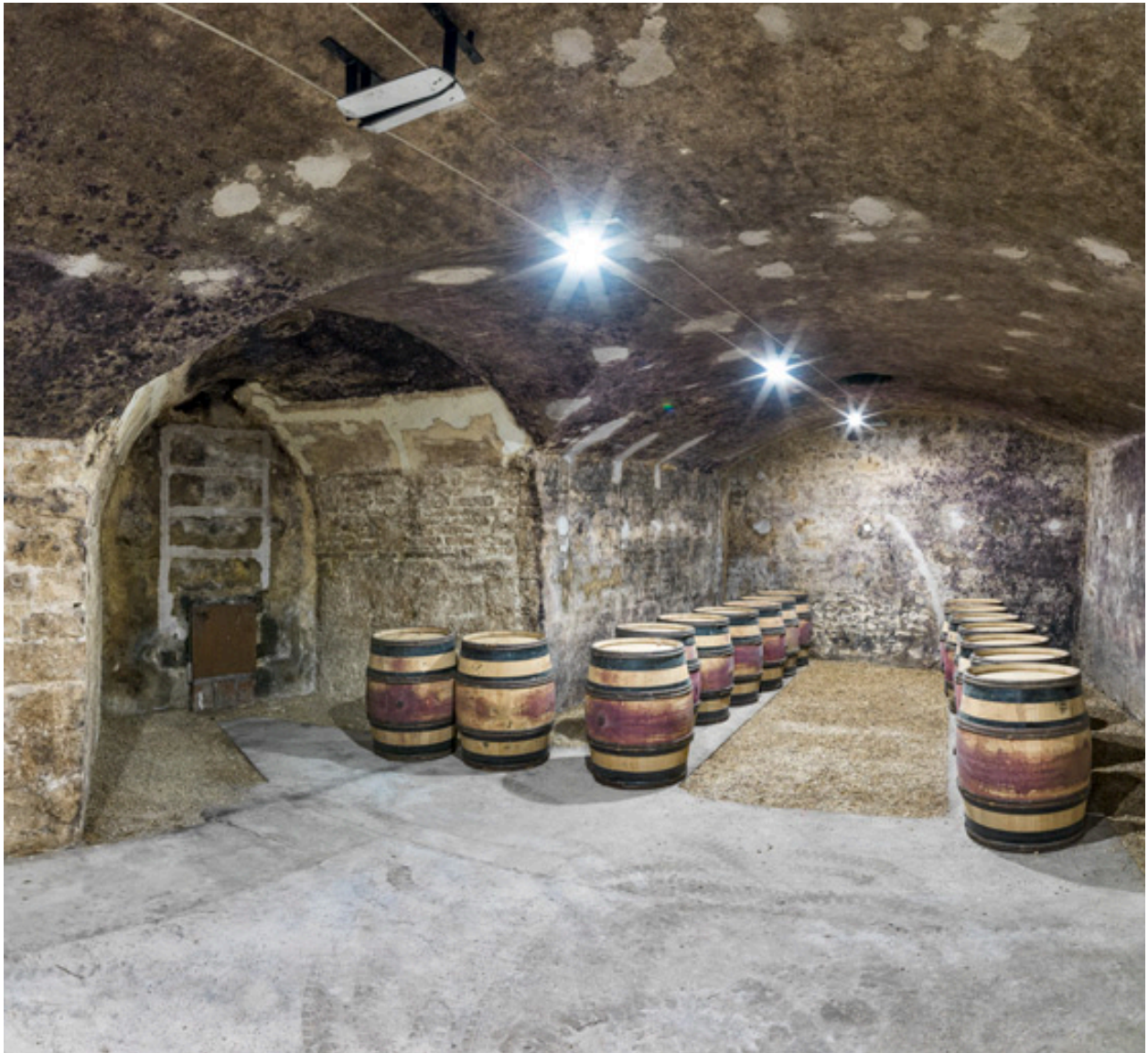
Caves, rez-de-chaussée : sur la gauche, niche d'une ancienne embrasure.
