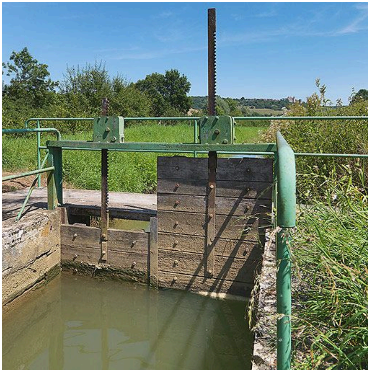
Vannes de régulation sur la rigole.
