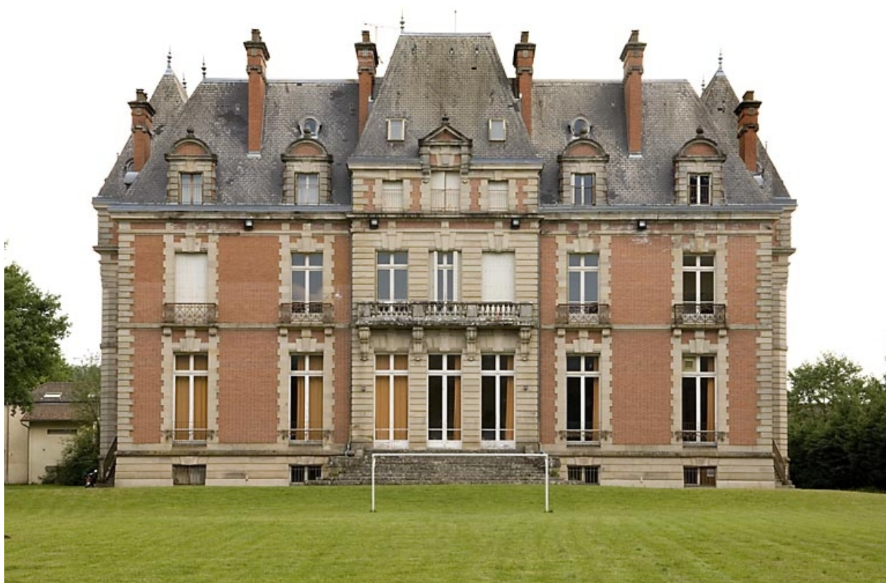
Logement patronal. Façade postérieure.
