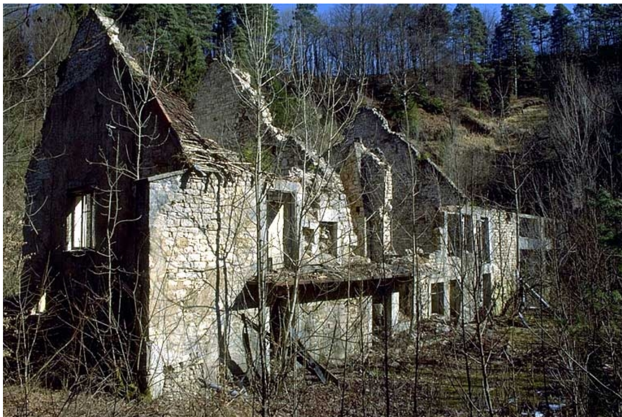
Logement patronal depuis le sud.
