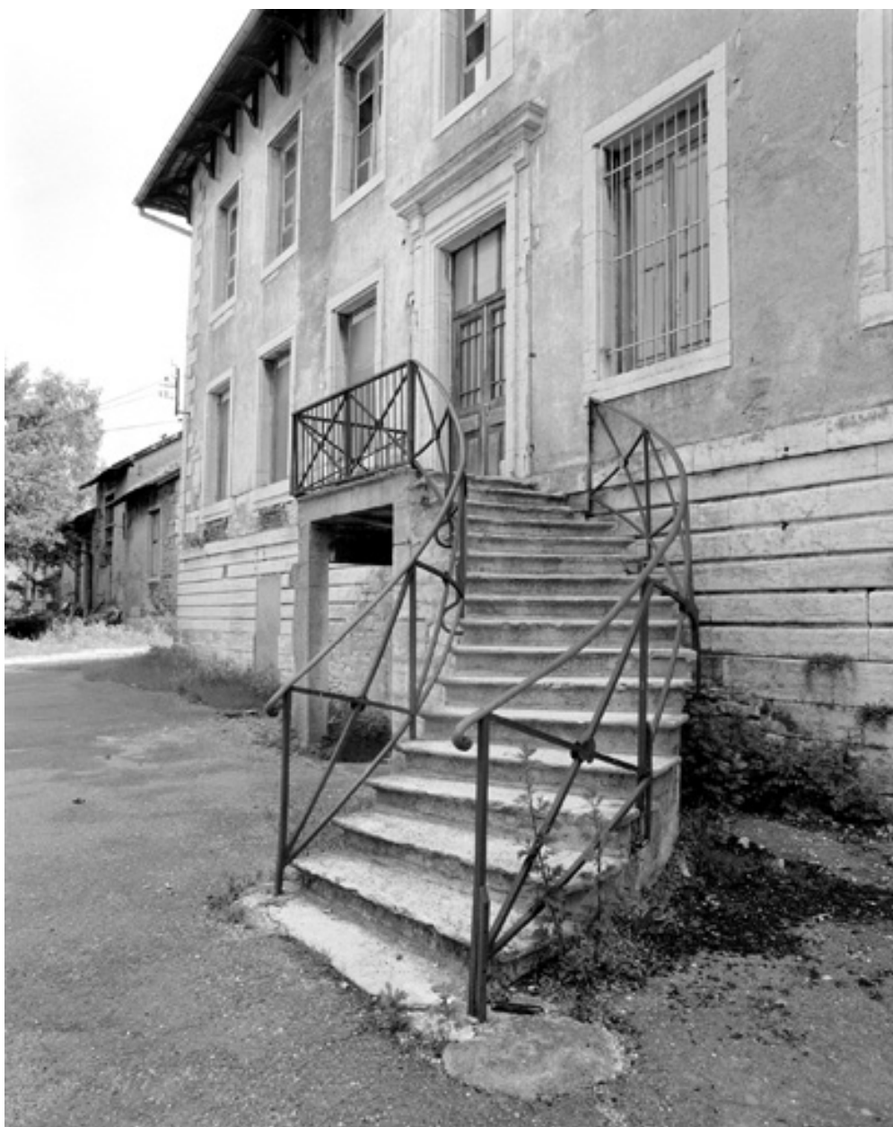
Volée droite de l'escalier.
