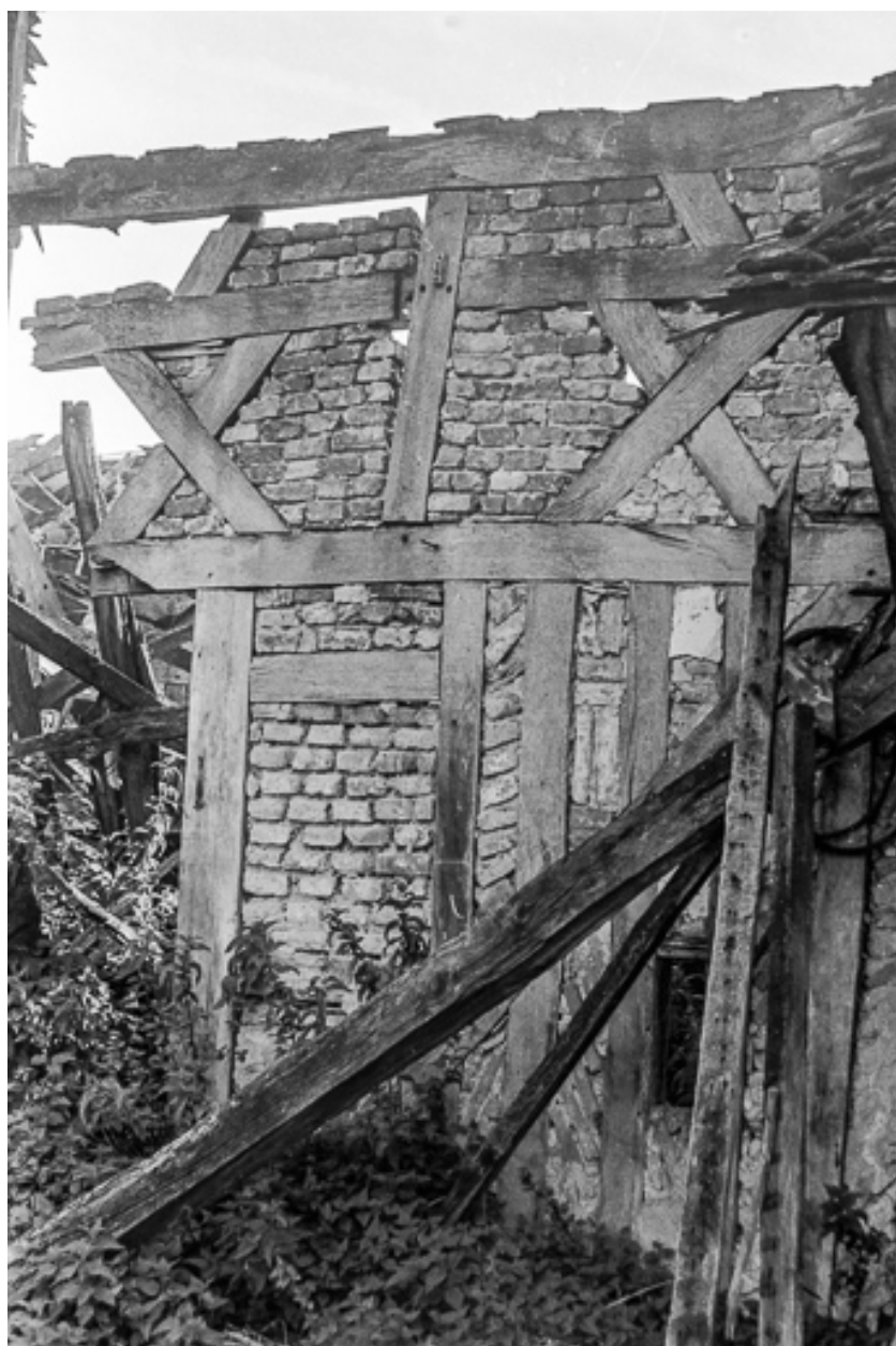
Ferme cadastrée 1956 A1 142-143 : détail du mur.
