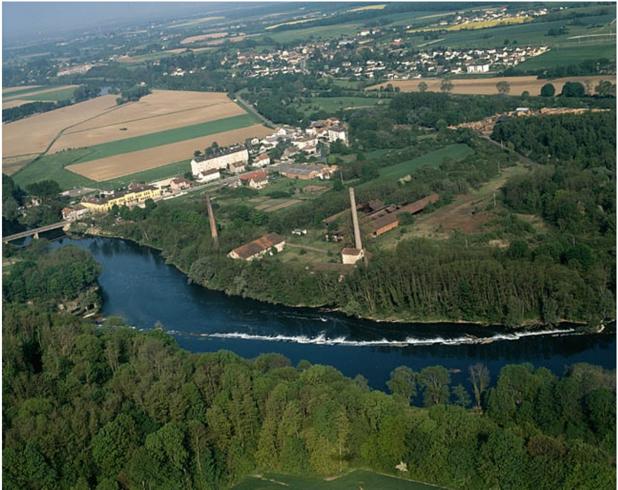
La Forge Neuve vue de l'est, photographie aérienne.
