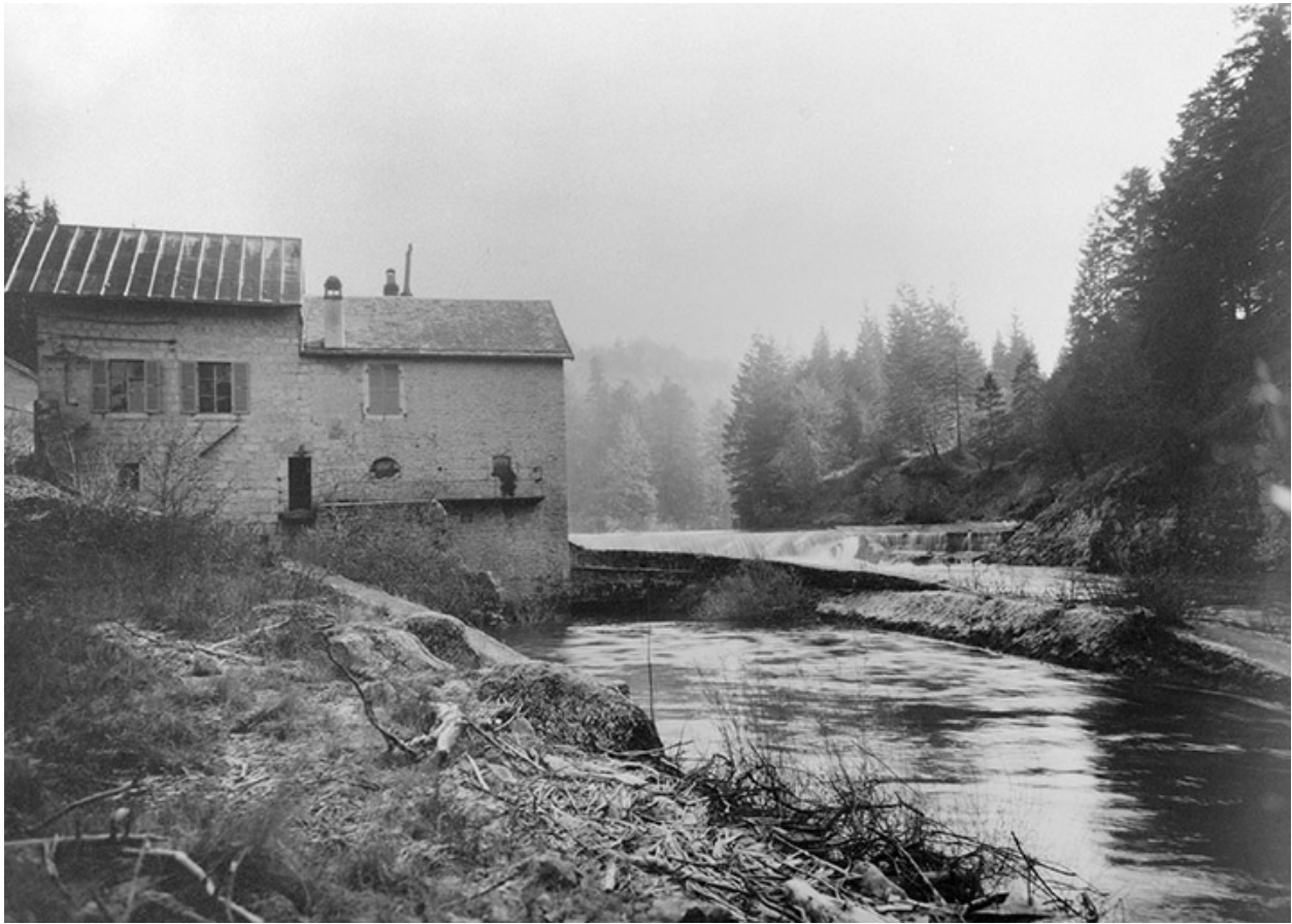
[Centrale hydroélectrique de la Roche] Vue générale, 1950-1951.
