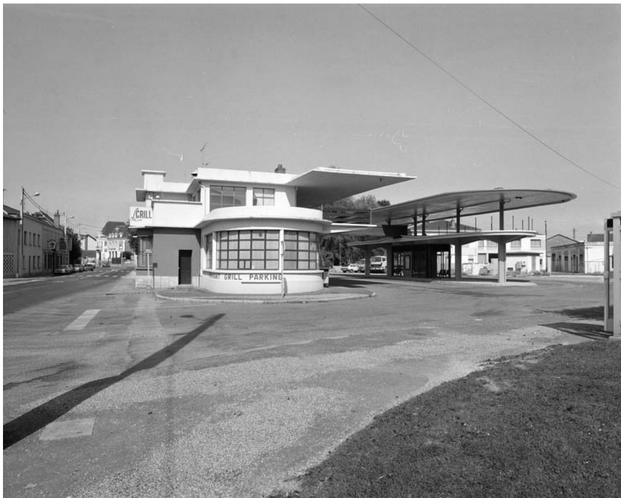
Façade latérale droite de trois quarts gauche.
