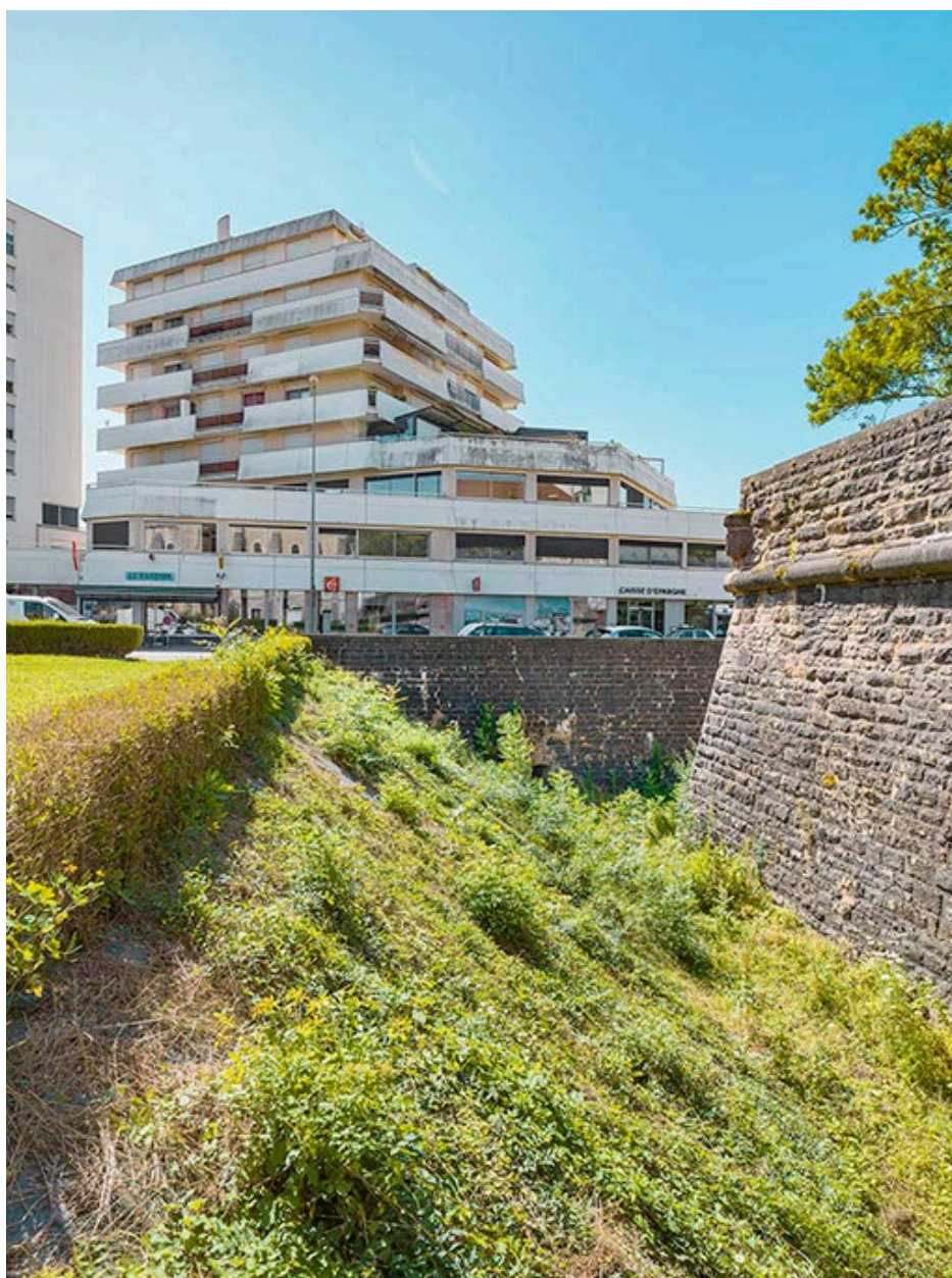
Le bastion Royal après restauration.
