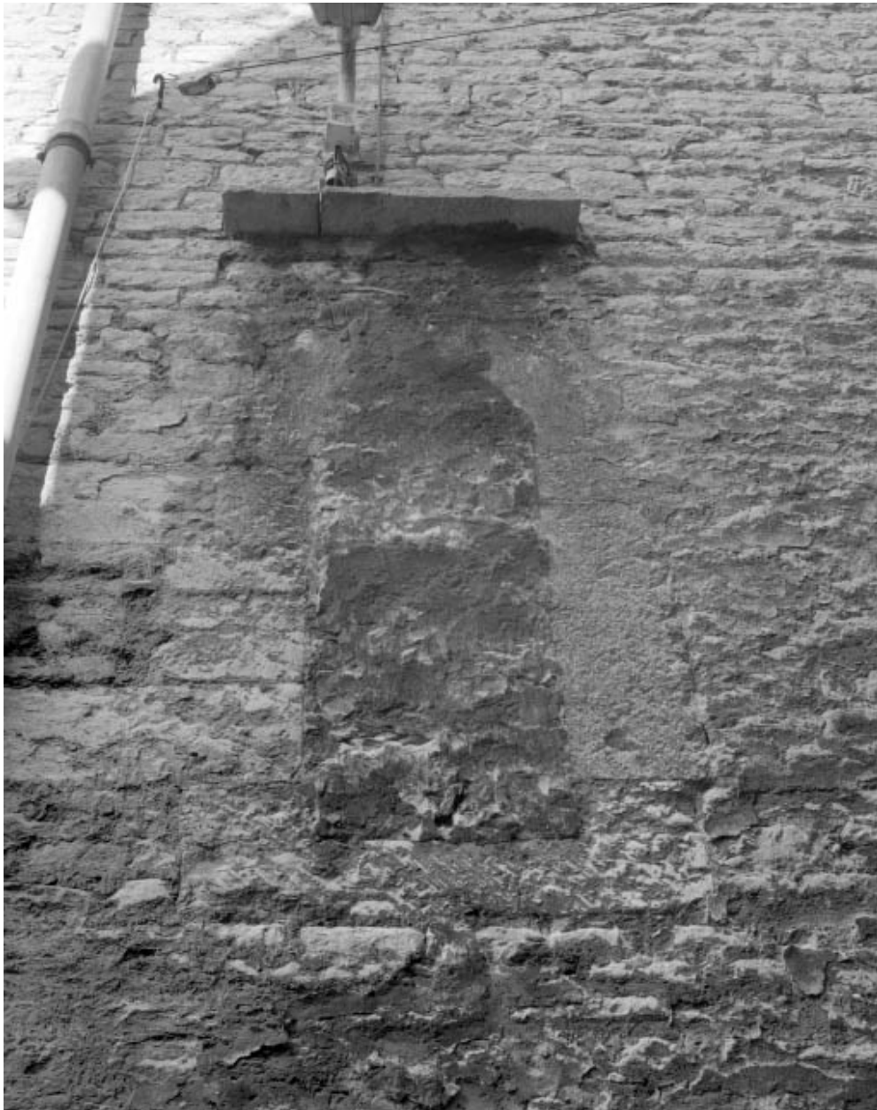
Façade latérale gauche : détail d'une baie murée.
