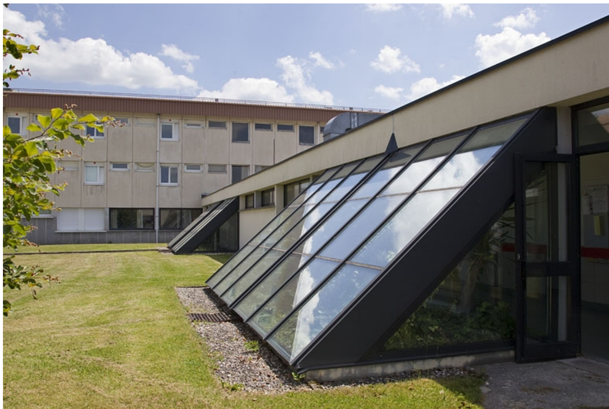
Bâtiment de la restauration : face nord.
