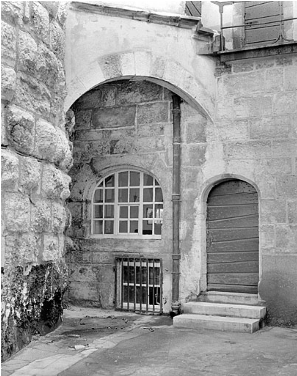
Arc soutenant la tourelle d'escalier de la tour Henriette.
