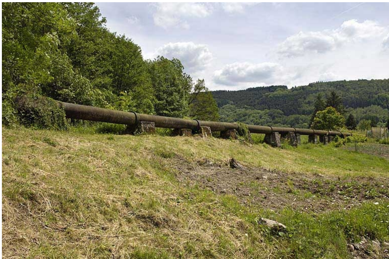
Conduite forcée de la centrale hydroélectrique.
