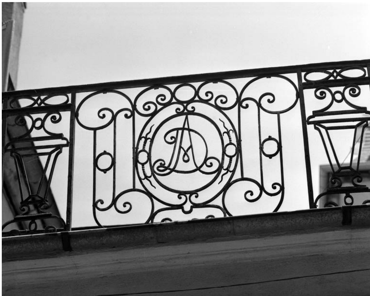
Portail d'entrée : détail du garde-corps en ferronnerie du passage découvert.
