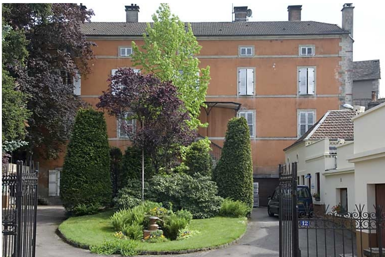
Vue d'ensemble depuis la rue.
