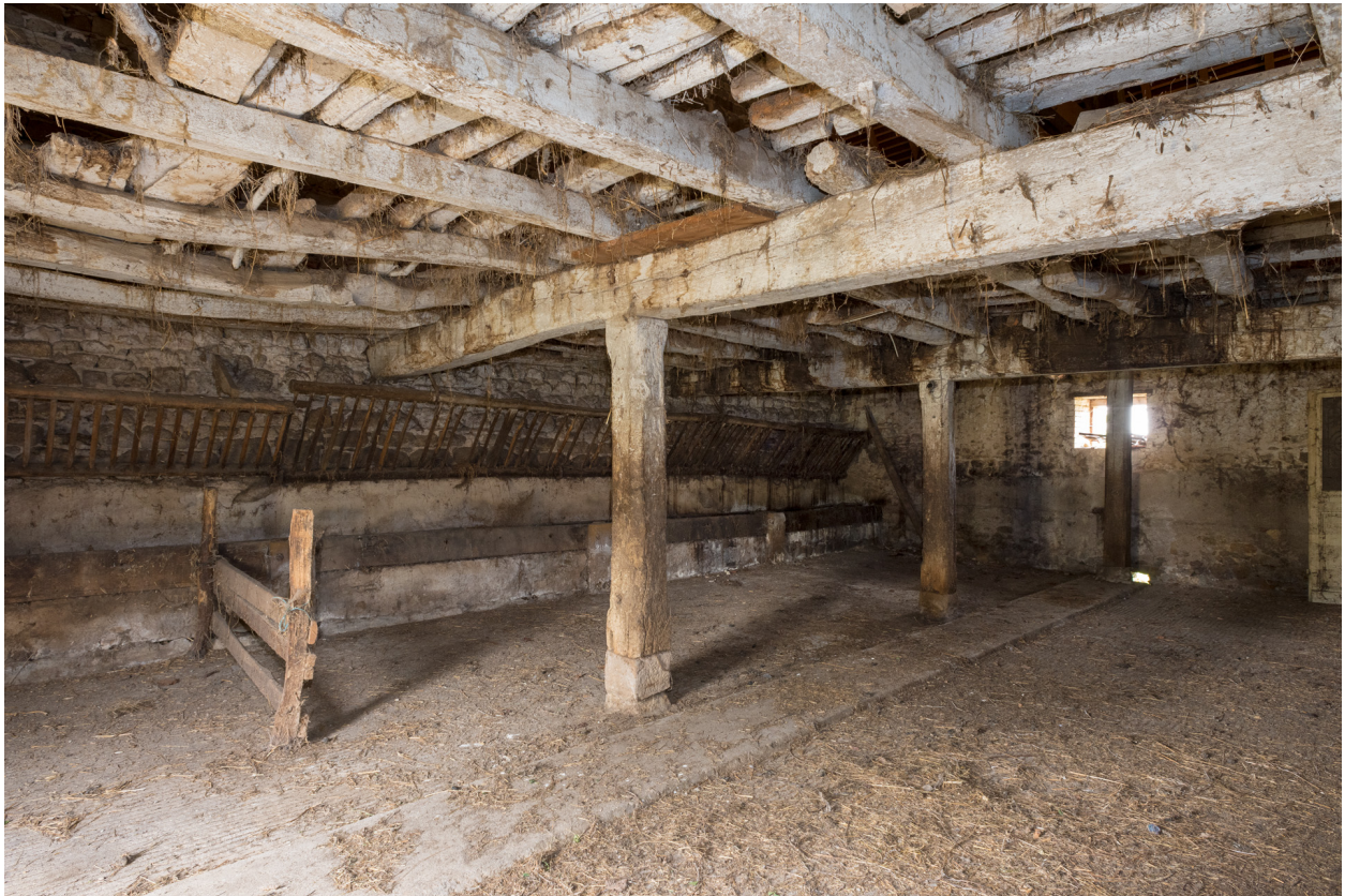
Vue intérieure de l'étable double, à gauche de la remise
