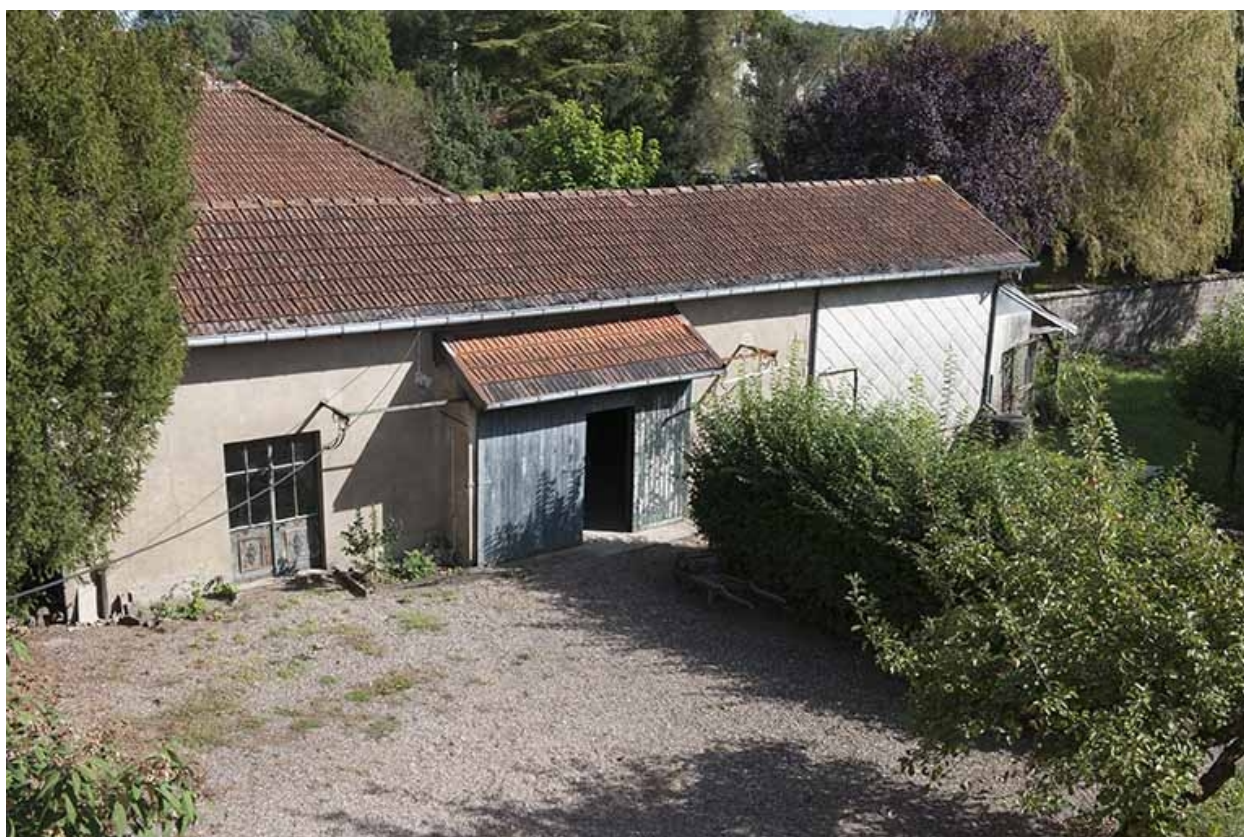
Vue générale de la remise.
