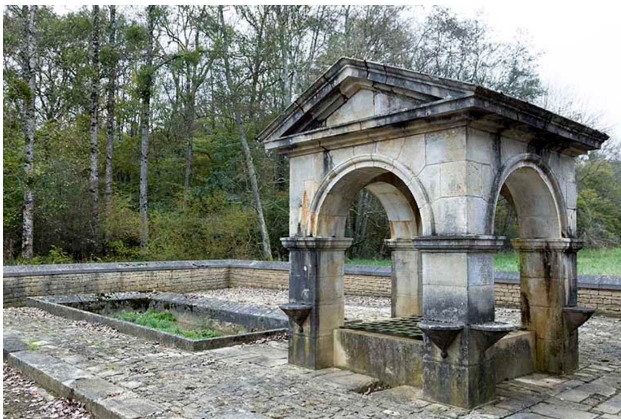
Puits et lavoir depuis l'abreuvoir.
