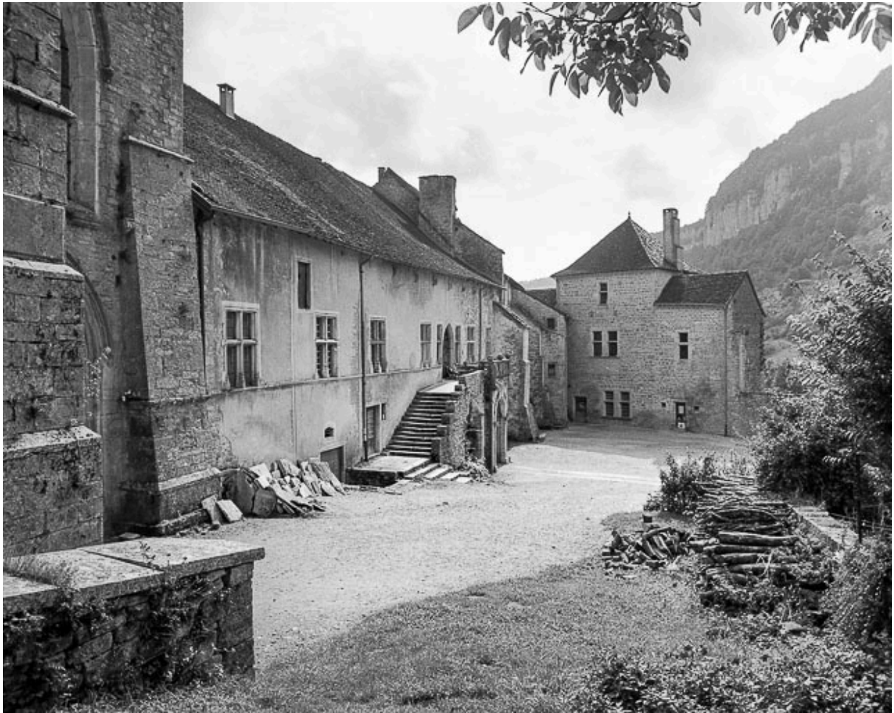
Quartier abbatial : élévation sur la grande cour, partie droite.
