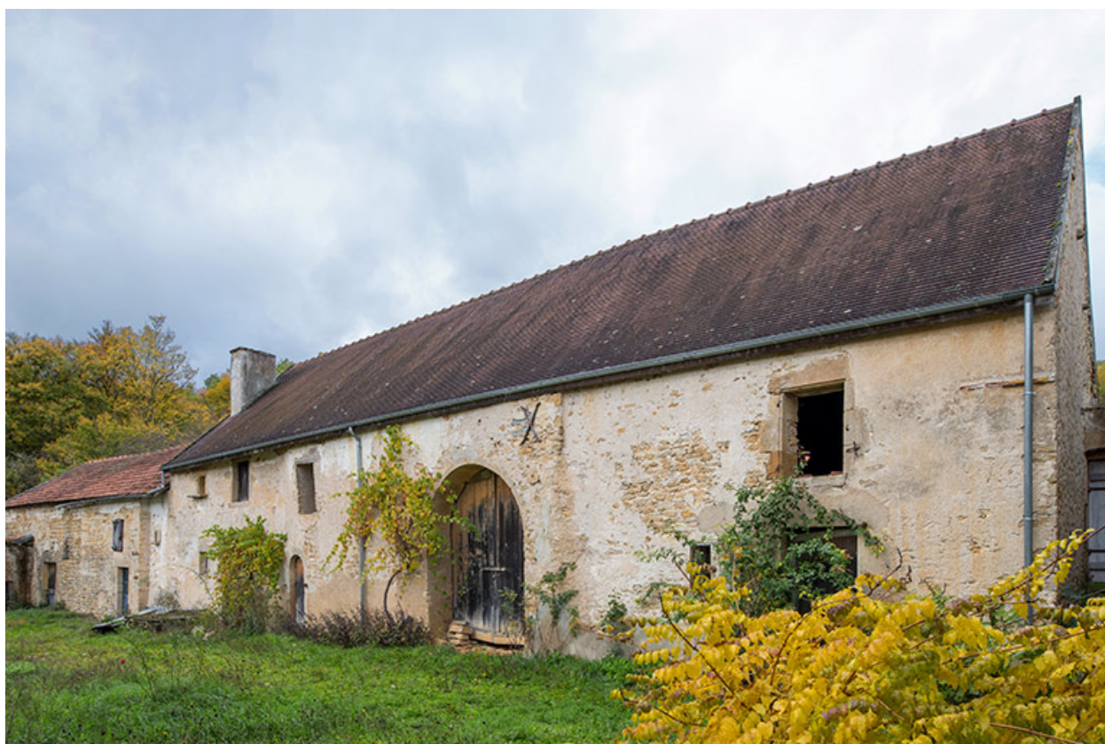
L'ensemble du corps de ferme, en direction de l'ouest.
