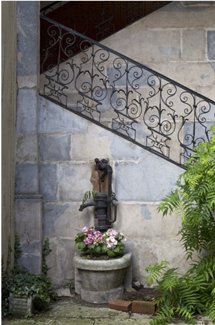
Escalier, première volée : détail de la rampe en ferronnerie et de la borne fontaine.
