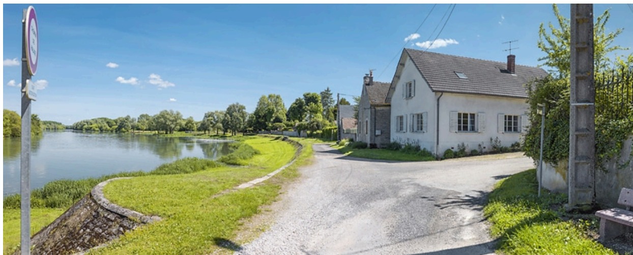
Tête aval de la digue.
