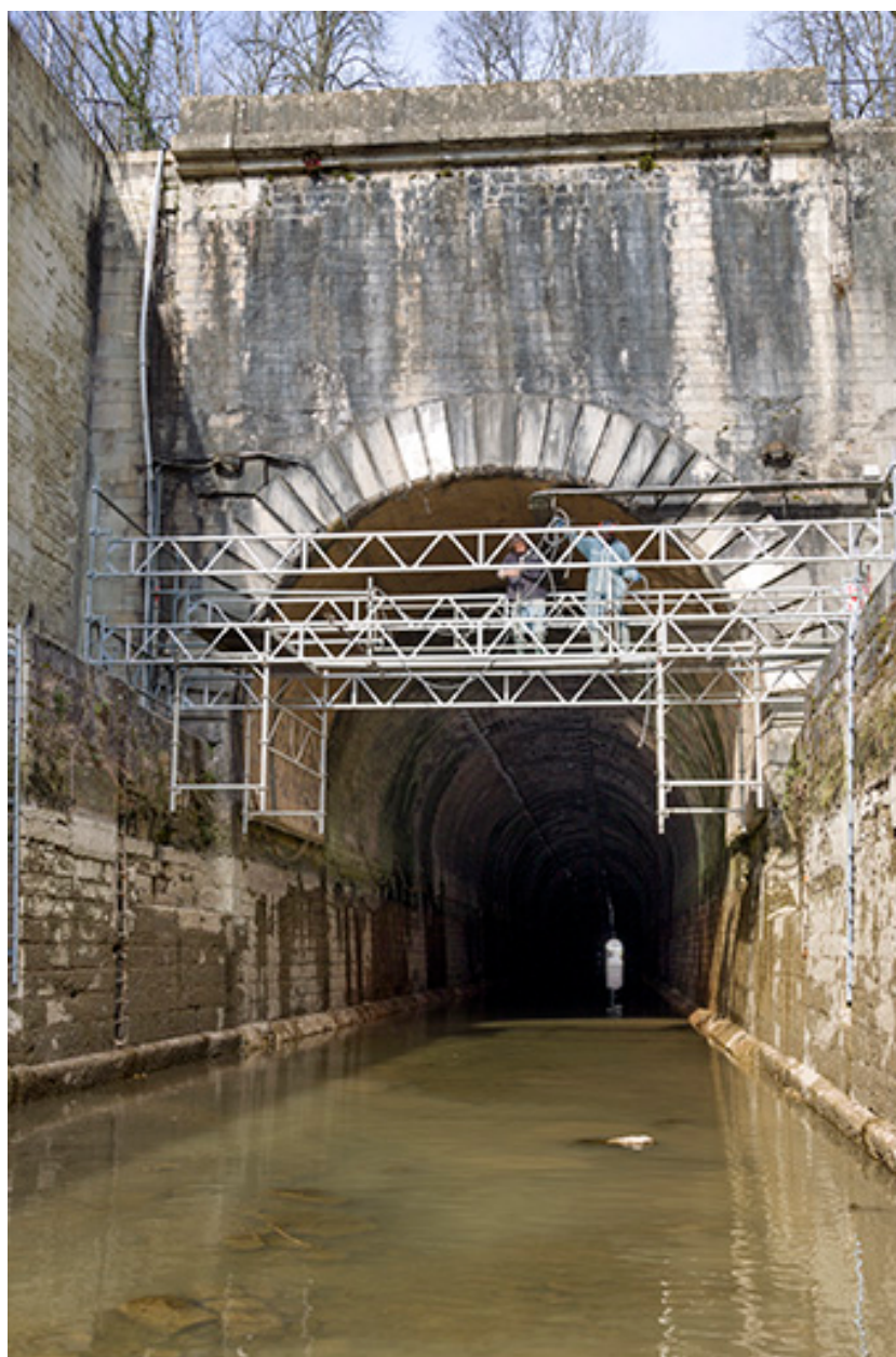
Entrée aval (restauration de la maçonnerie 2015).
