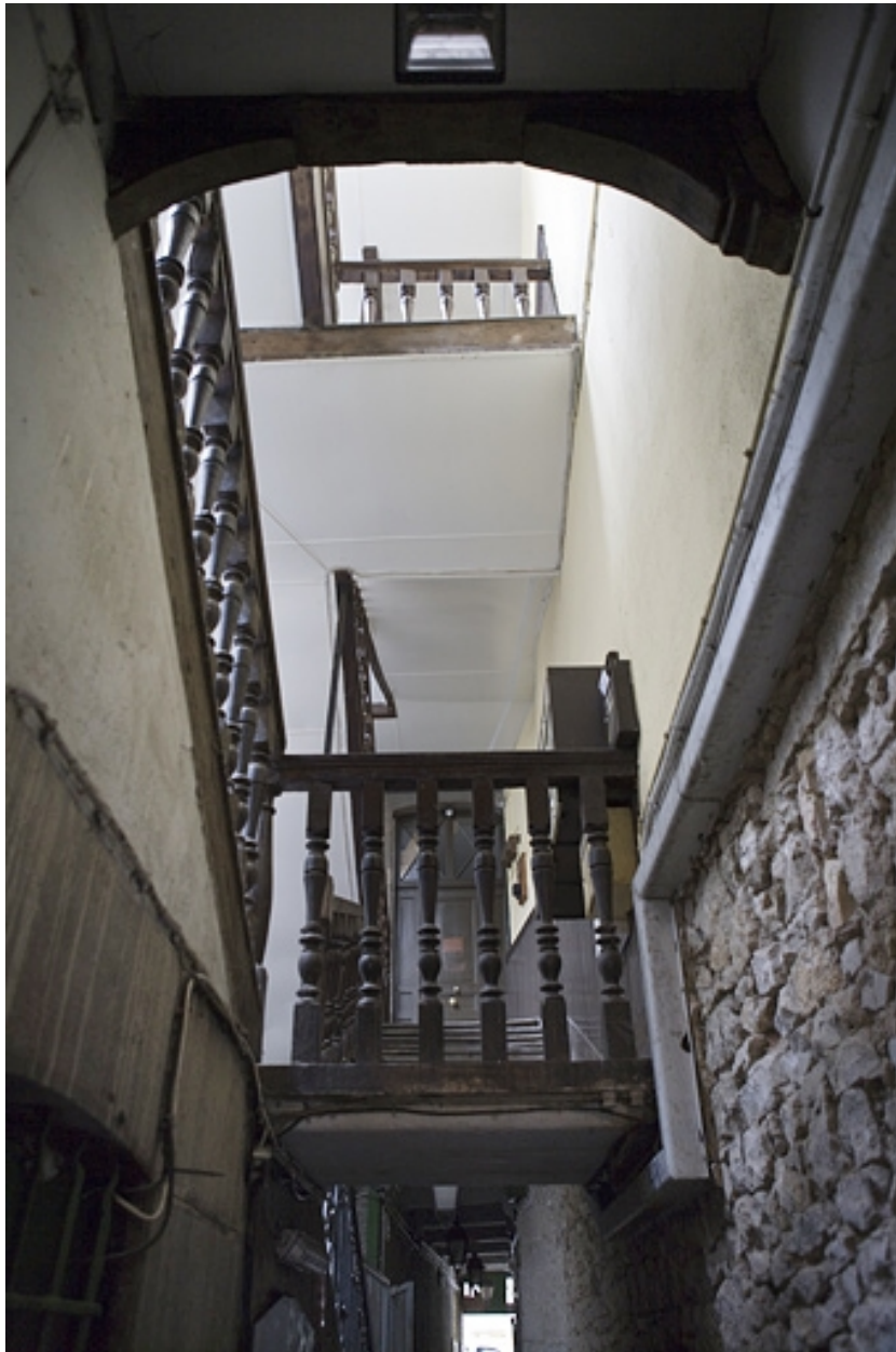
Détail de l'escalier à cage ouverte dans la première cour : 13 Grande Rue.
