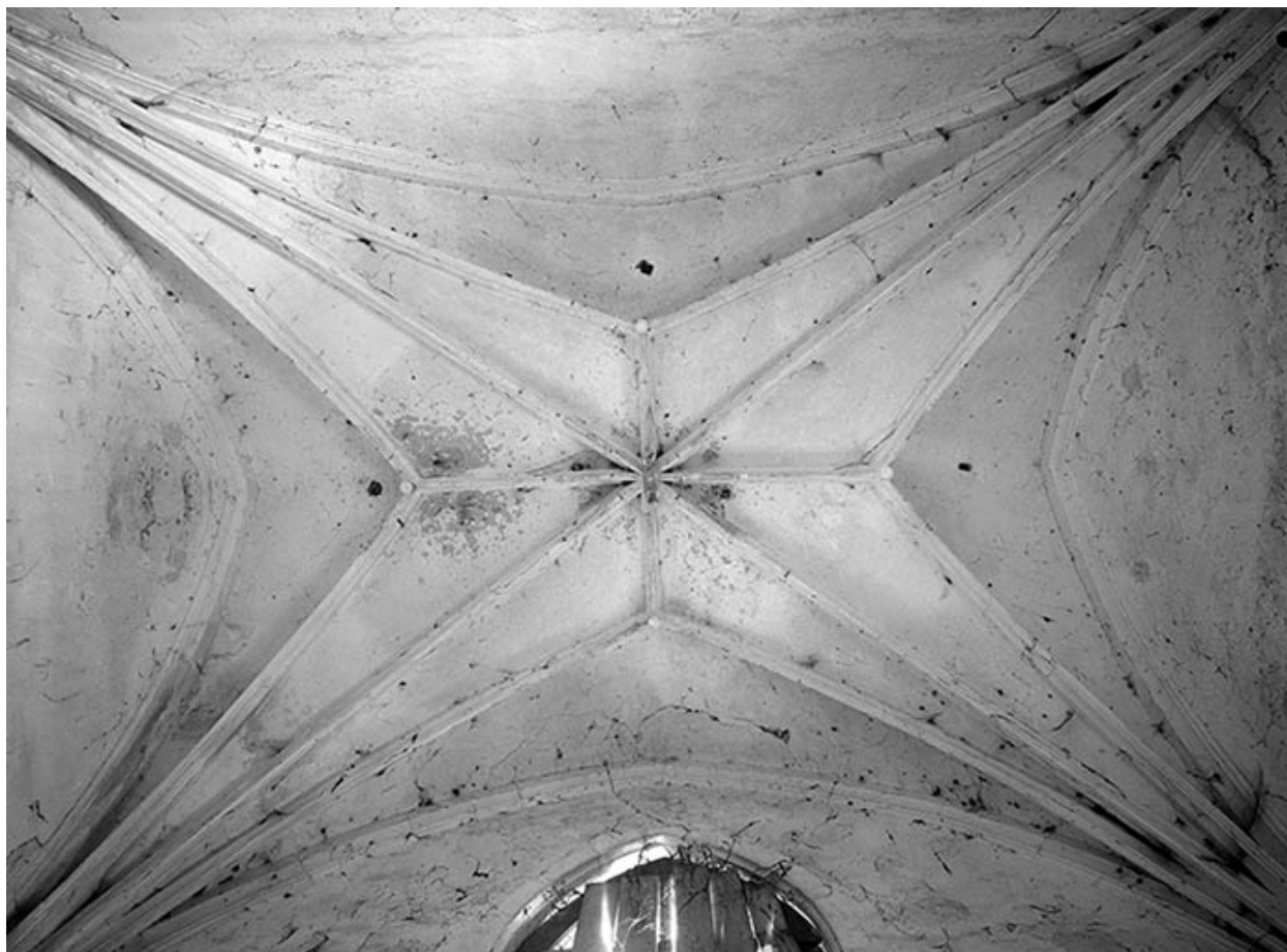
Vue d'ensemble de la voûte.
