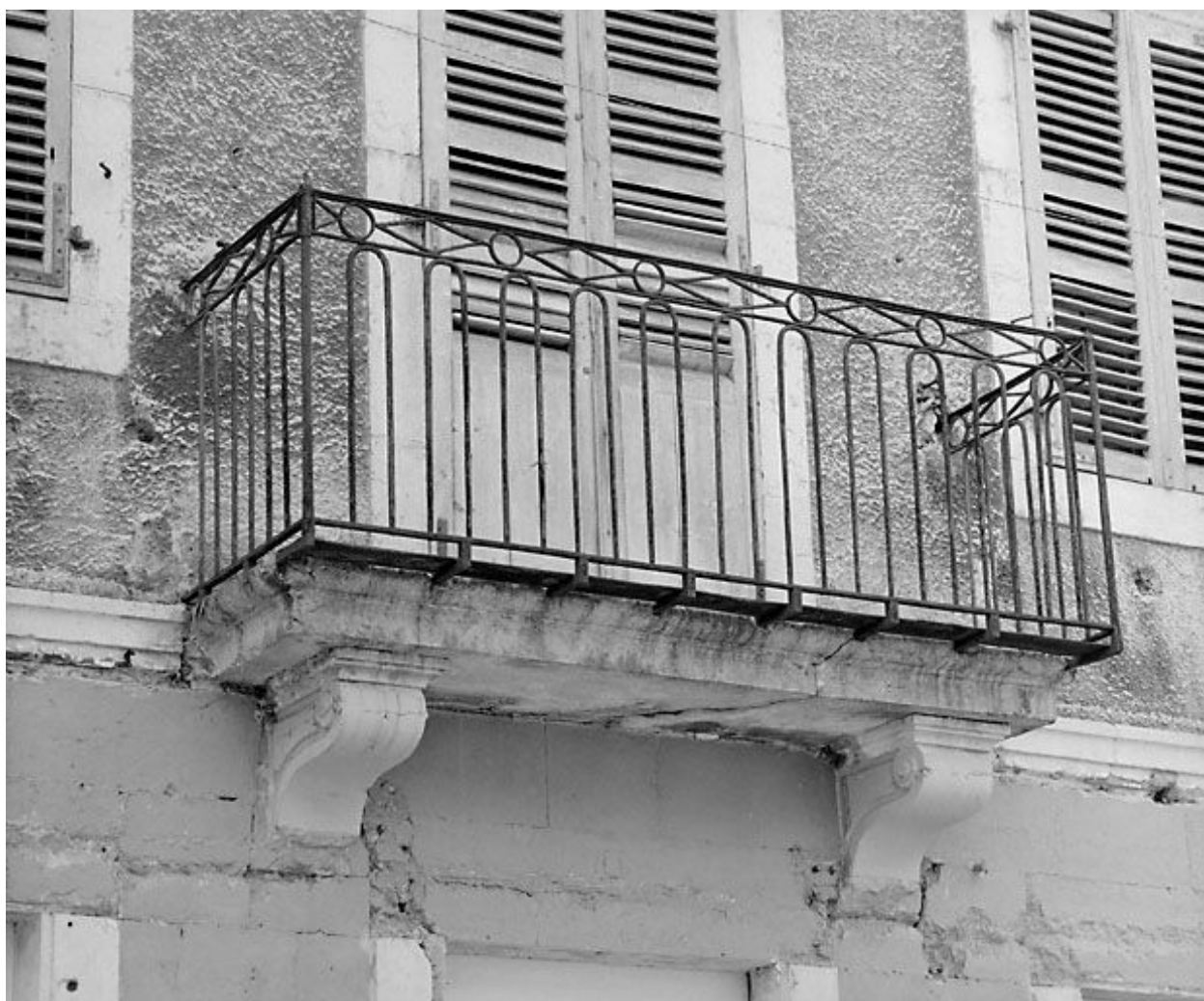
Balcon du corps de bâtiment oriental.
