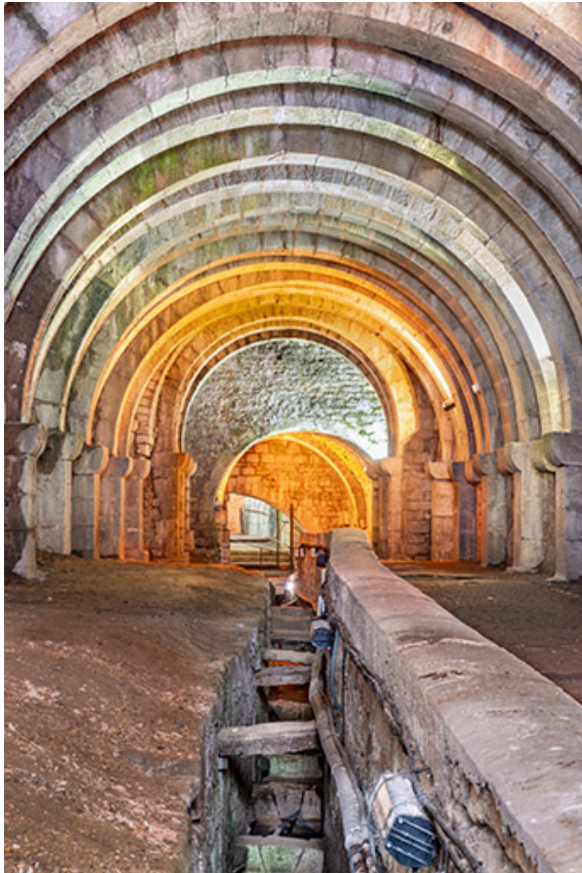
Partie nord de la galerie de communication entre les deux puits.
