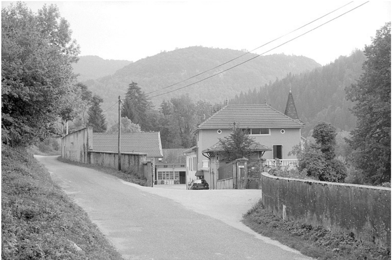
Entrée de l'usine et logement patronal.
