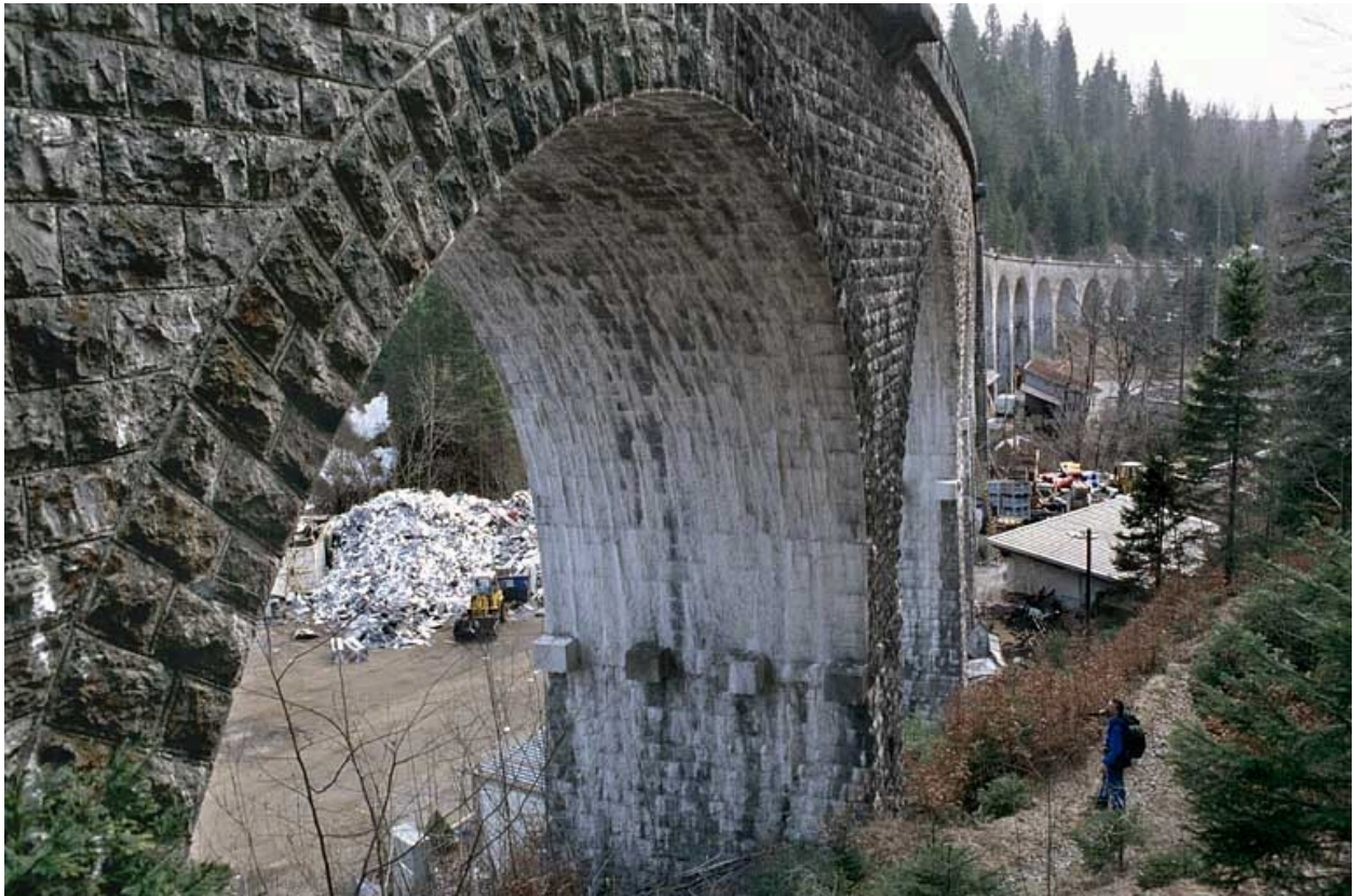
Une arche côté Andelot-en-Montagne, vue en enfilade.
