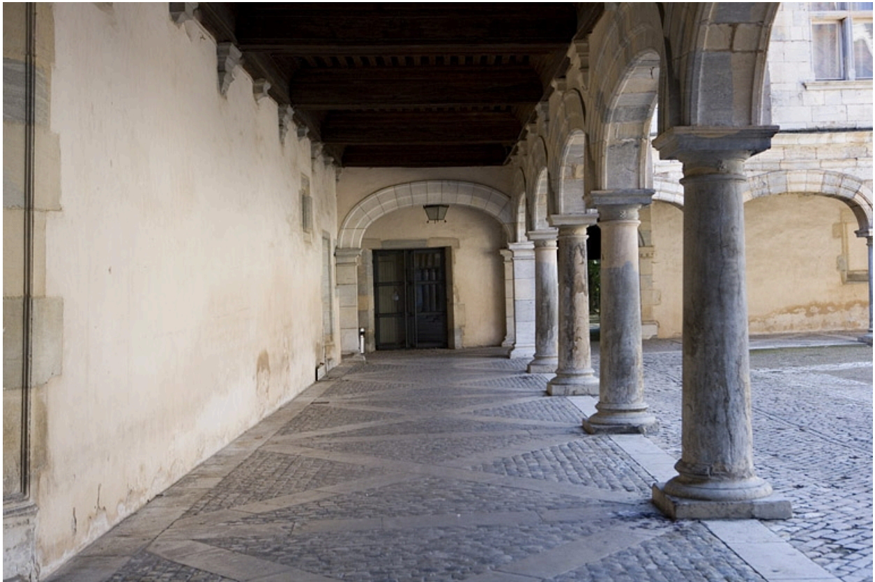
Vue du portique depuis le portail d'entrée.
