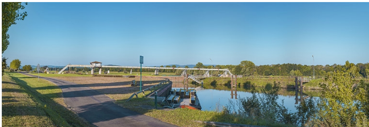
L'entrée amont du site d'écluse.
