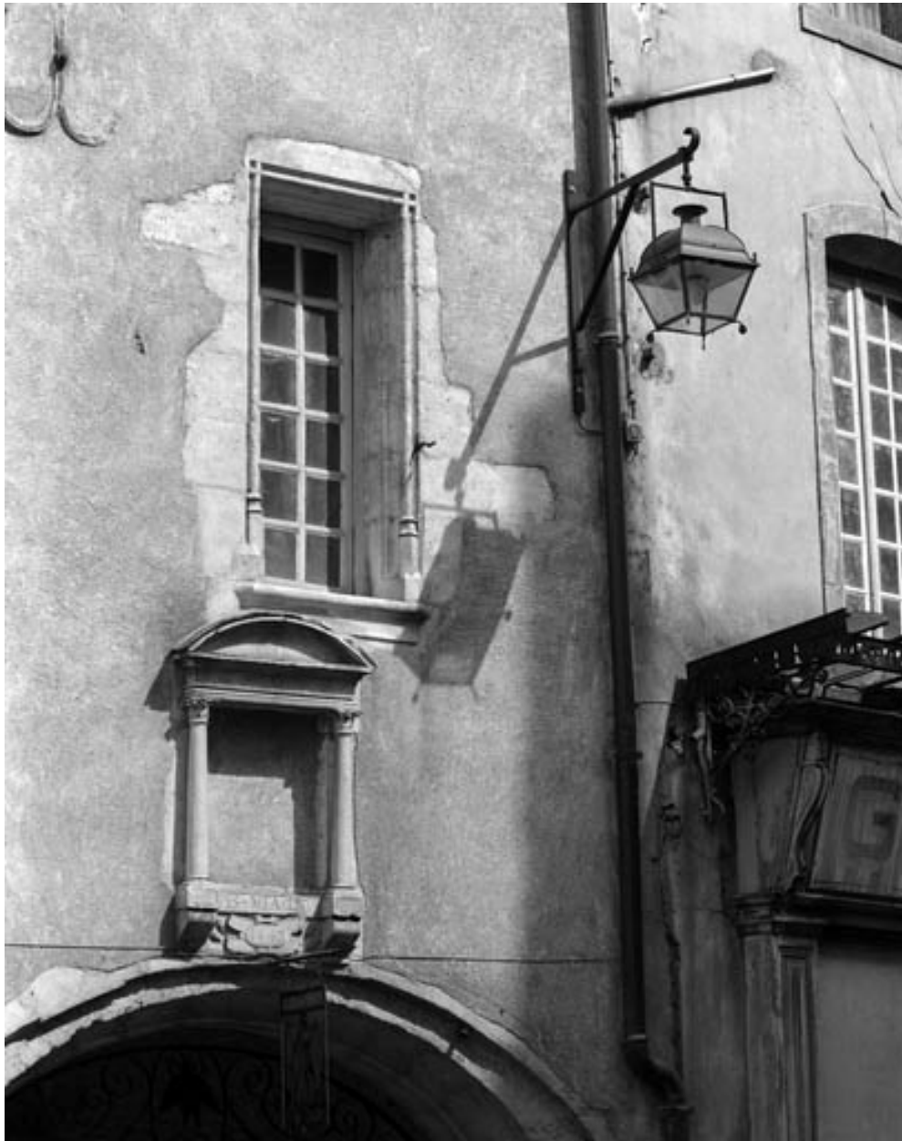
Façade antérieure : partie droite, niche et fenêtre au-dessus du portail d'entrée.
