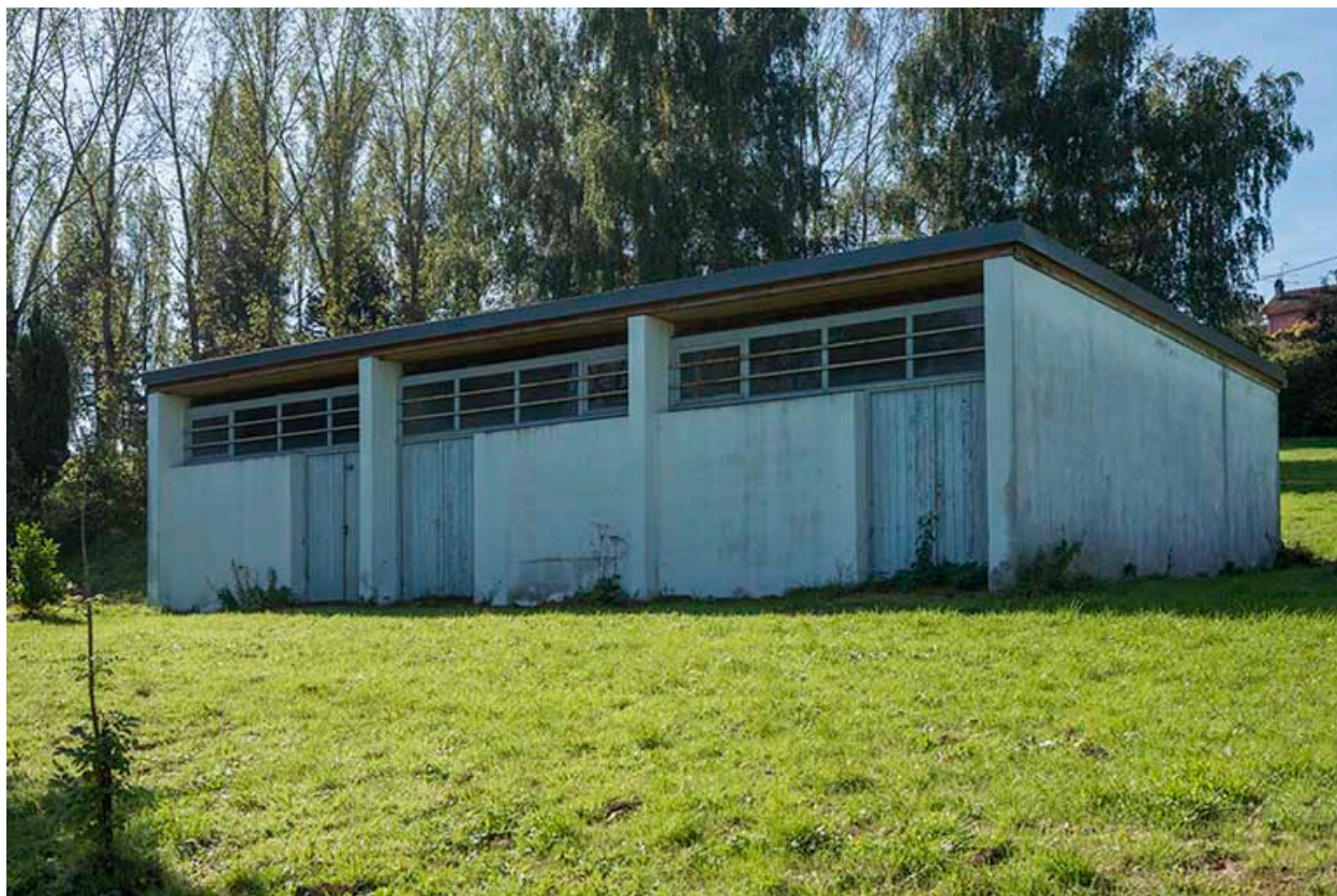
Angle nord-ouest et façade nord-est du dépôt.
